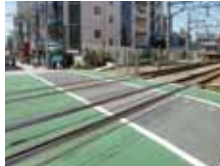
自由が丘駅大井町線踏切を安全のためカラー舗装化
