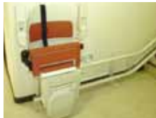
宮前分室昇降機設置
